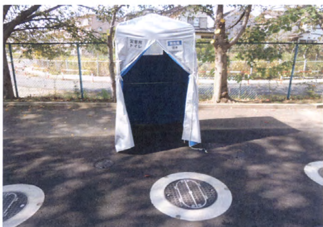
⑩ トイレのテント組立状況
