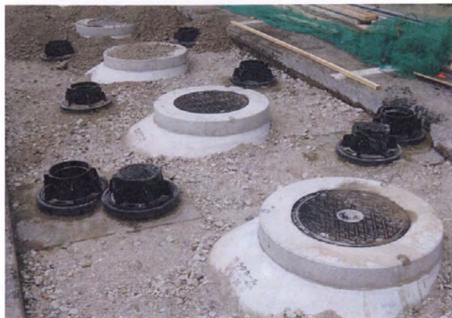
⑧ 碎石等で埋め戻し
