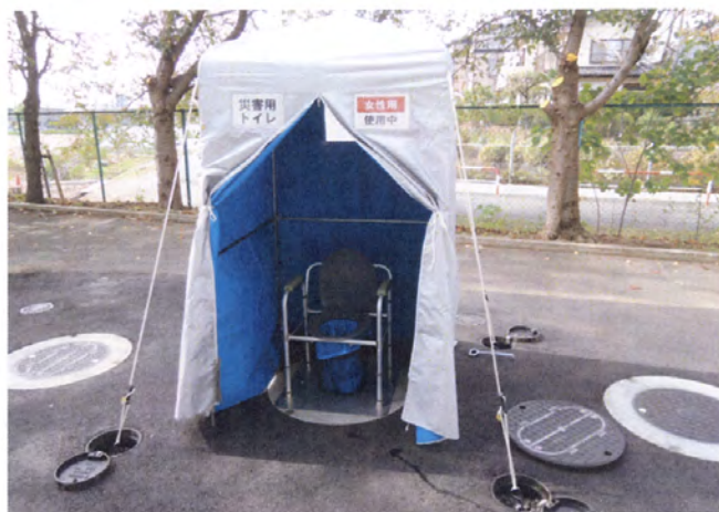
⑪ トイレテントを設置 (専用テント支持金物にロープで固定)
