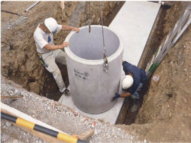
① 所定の位置に本体 (便槽) を設置
