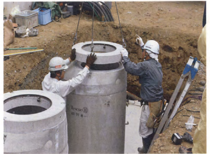
④ 天端に調整リング* 固定ボルトを設置
